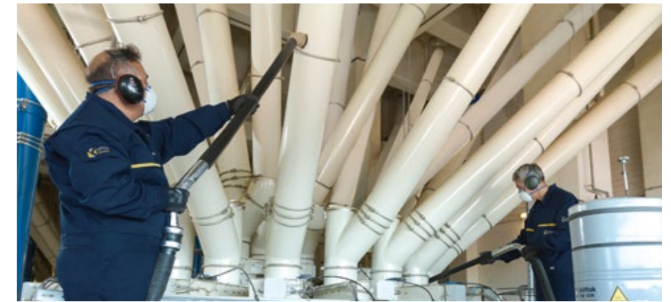
Mit Hochleistungs-Industriesaugern bearbeiten die Reinigungsspezialisten die riesigen Anlagen sowie zahllosen Rohre.
