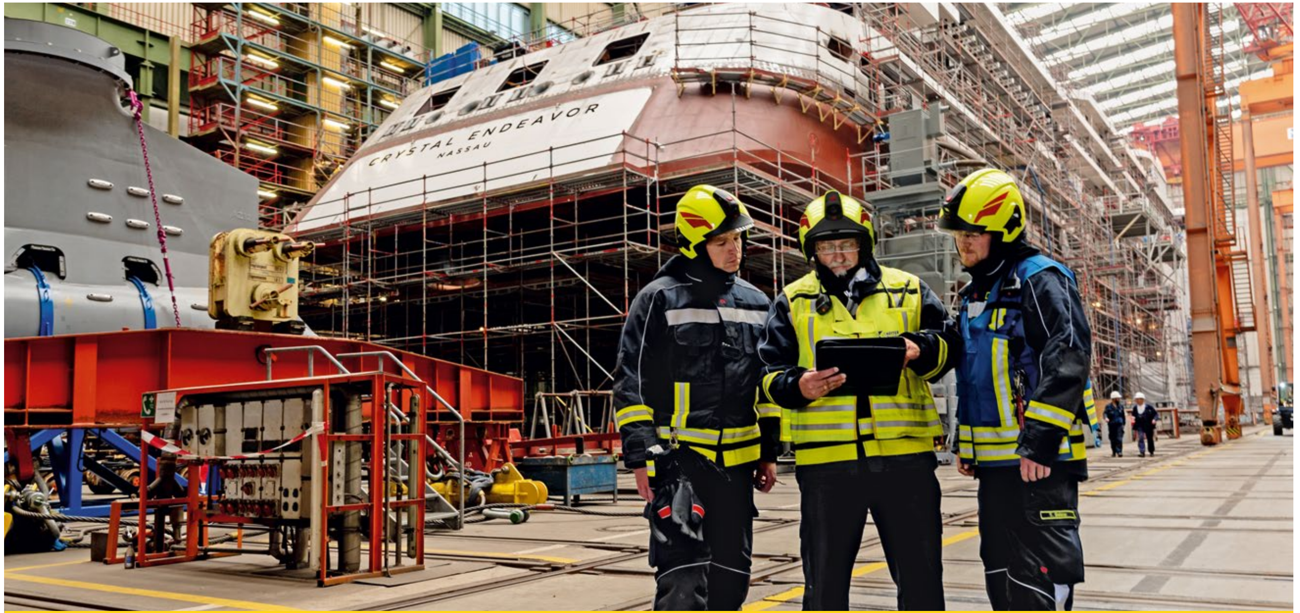
Lagebesprechung in der 300 Meter langen Schiffbauhalle.
