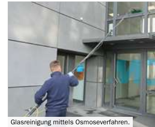
Glasreinigung mittels Osmoseverfahren.
